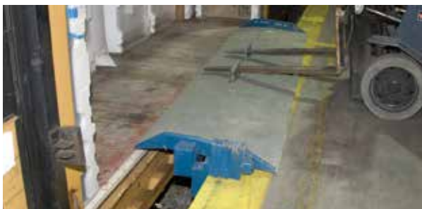
Colocación de Placa de Ferrocarril
